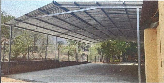
**Foto 1:** Colocación de losa de concreto en el patio de la escuela y su respectivo techo con lámina troquelada calibre 26, su estructura metálica de tubos galvanizados chapa 16, con su canal y bajada de agua pluvial.
