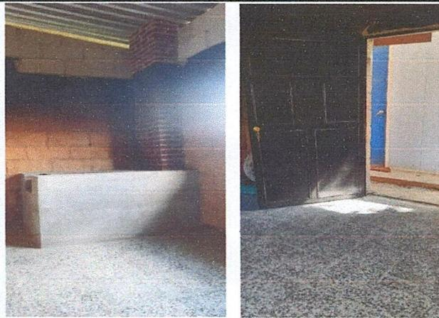
**Foto 3:** Remozamiento de cocina, con estufa de gas y de leña, chimenea, puerta, ventana estructura metálica, lámina troquelada calibre 26 y con piso de granito. Mejora de altura de las paredes, e instalación de energía eléctrica.
